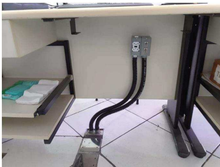
Imagem 33 – Instalação de tomadas elétricas e lógicas dos guichês
