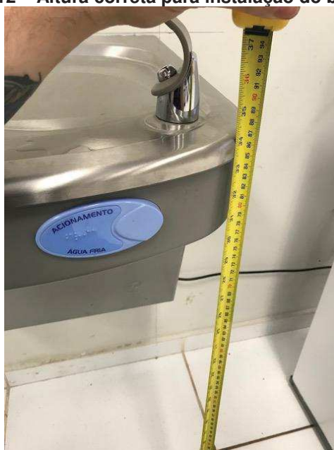
Imagem 12 – Altura correta para instalação do bebedouro
