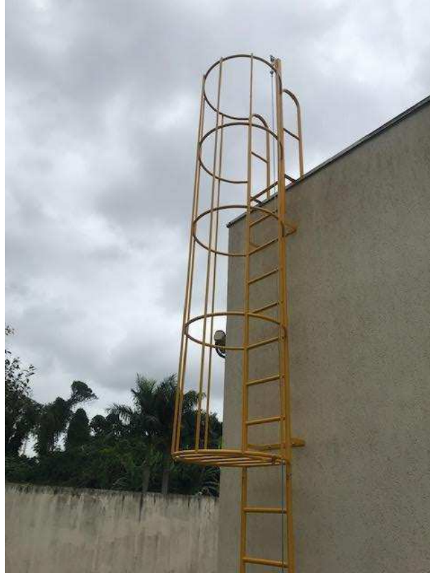
Imagem 39 – Modelo de escada marinheiro a ser executada
